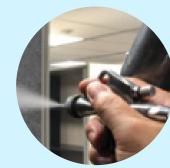
將納米銀光觸媒以高壓噴槍 打到每一個接觸面,大大提 高塗層與表面之融合性。
